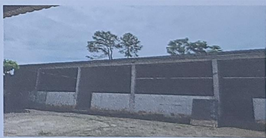
Foto 6: Terminación de módulos
