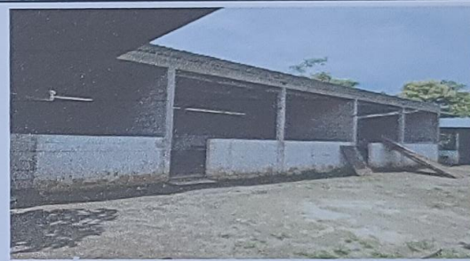
Foto 4: Terminación de techo de aula
