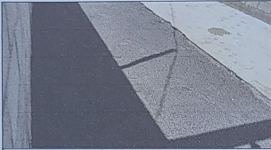
Foto 3: Terminación de piso de aulas
