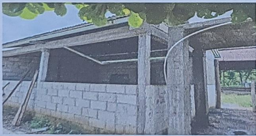
Foto 5: Terminación de techo cocina
