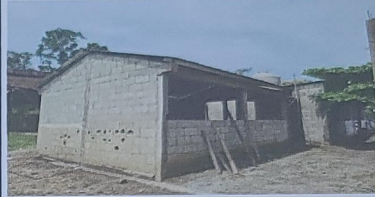
Foto 2: Terminación de cocina y colocación de laminas
